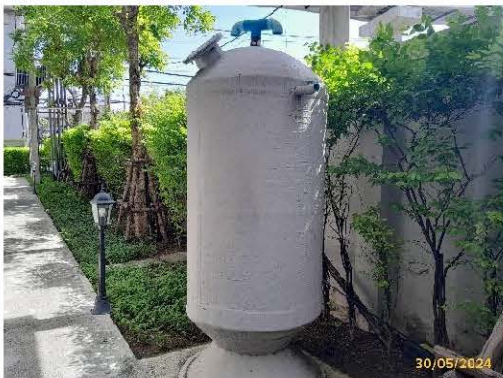
ระบบกำจัด Aerosol และระบบกำจัดมีเทน อาคาร A
