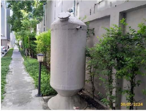
ระบบกำจัด Aerosol และระบบกำจัดมีเทน อาคาร B
