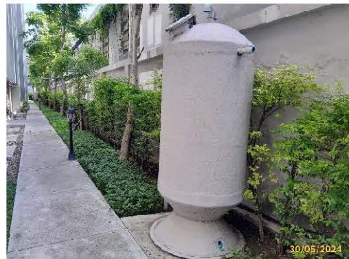
ระบบกำจัด Aerosol และระบบกำจัดมีเทน อาคาร A
